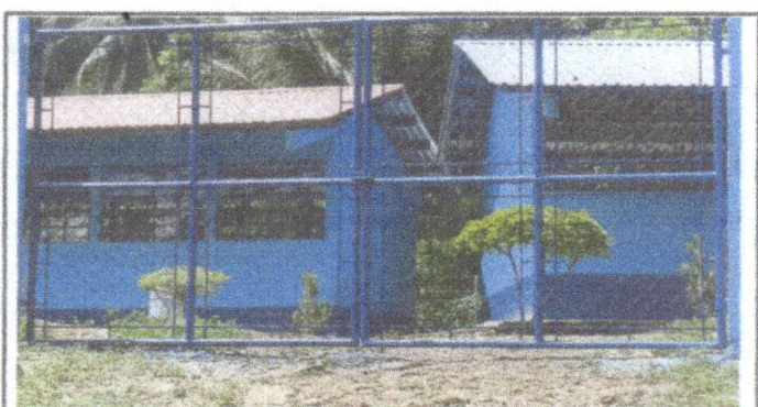
Foto 6: portones reparadas y pintadas por herreros
