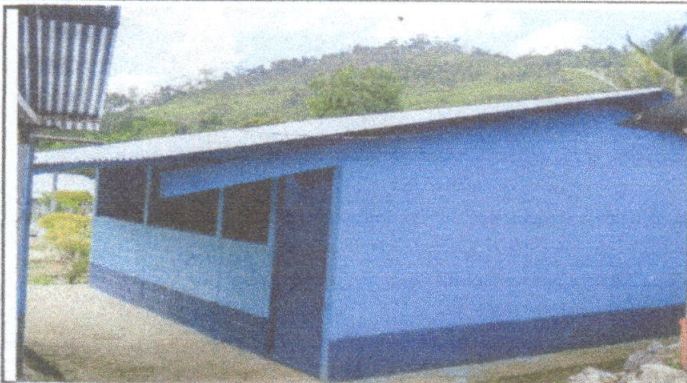
Foto 1: La cubierta de lamina del Modulo I, ya fue instalada por los trabajadores especializados.
