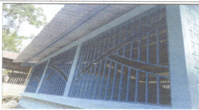
Foto 2: Los balcones ya fueron instalados en su respectivo lugar por lo trabajadores, en la parte de atrás.
