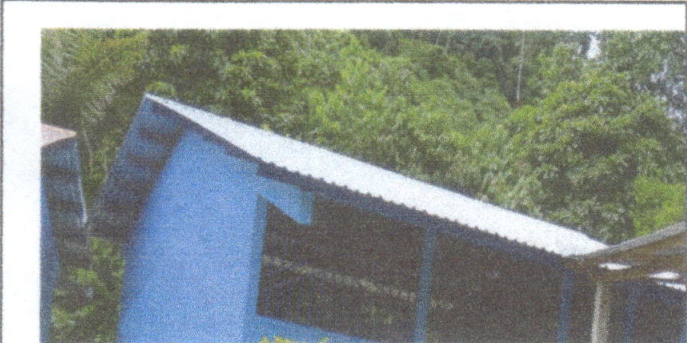
Foto 3: Balcones instalados en la parte de enfrente de las instalaciones
